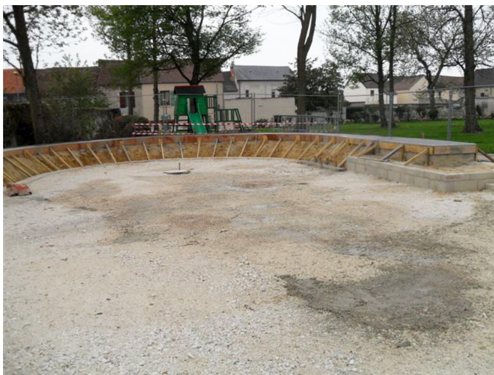
Le skate park encore en construction.
