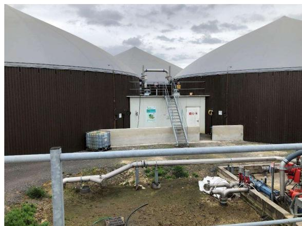
La digestion de ces ingrédients produit le méthane qui s'accumule dans les bâches de toits (chapeau gris visible depuis la route). Après être passé dans **les digesteurs** (c'est le nom qu'on donne aux cuves), le gaz va ensuite à la **purification** (photo ci-dessous) où il est traité pour respecter les normes de qualité demandées par GRDF.
